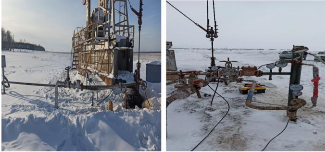
Рис.1 УЭЦН и СК (скребковая очистка ГНО, подача деэмульгатора в межтрубное пространство);
